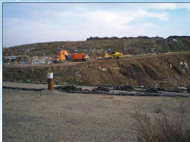
Všední den na tělese skládky. Vozidla linear press při vykládce odpadů; foto Ing. Roman Farion
