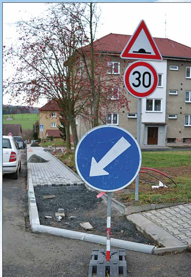
Rekonstrukce chodníku v ulici Nad Školou; foto archiv města
